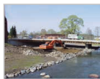
Brücken- und Gewässerbau
