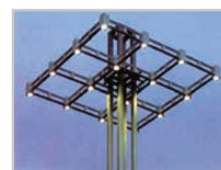
Filigrane Stahlkonstruktion (h=18m)
