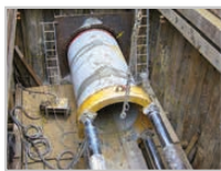
Kanalbau und -sanierung
