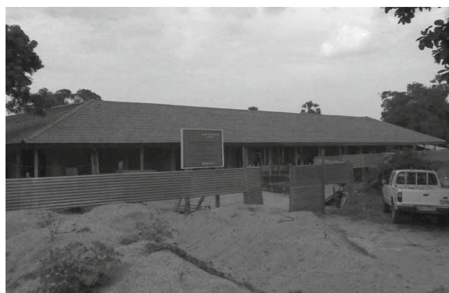
Der Rohbau ist fertig
