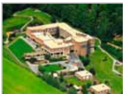
Umbau Kath. Akademie Schwerte
