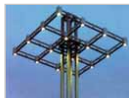
Filigrane Stahlkonstruktion (h=18m)
