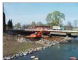
Brücken- und Gewässerbau
