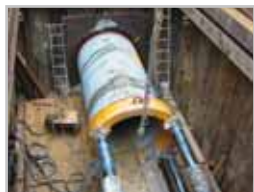
Kanalbau und -sanierung
