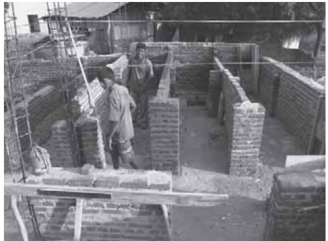
Der Sanitär- und Küchenbereich wird gemauert
