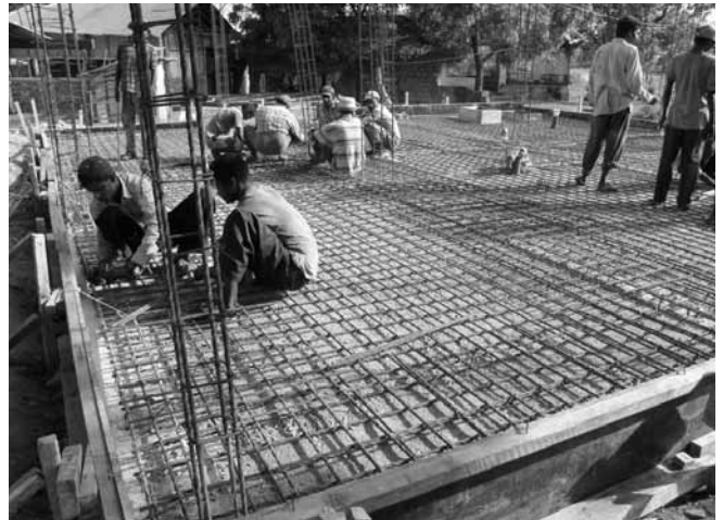
Die Fundamente der neuen Klinik in Sri Lanka sind fertig
