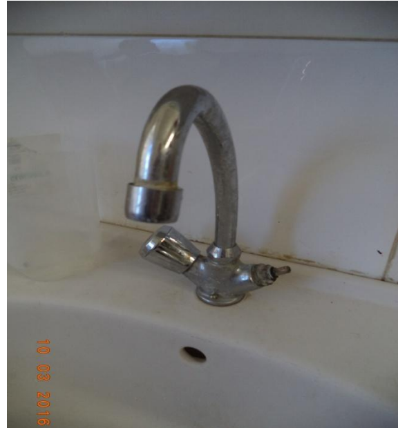
Rep. von sanitären Anlagen
