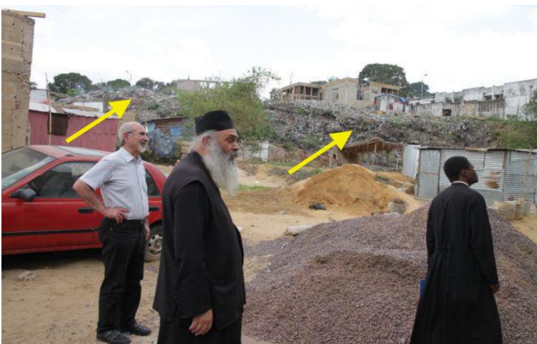
Das Gesundheitszentrum wird in einem Slum an der Peripherie von Kinshasa direkt neben der Deponie gebaut.
