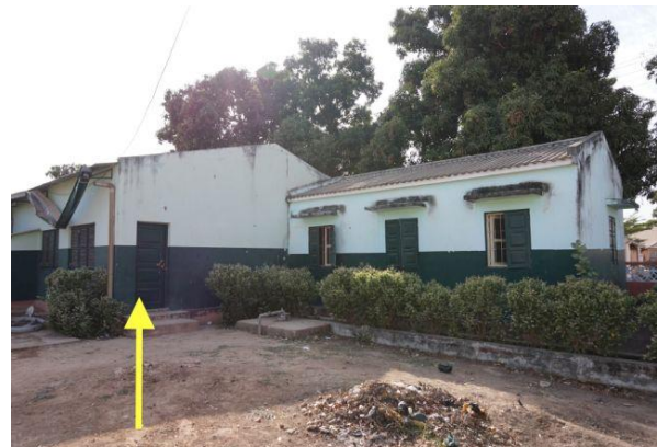
Dieses Gebäude (Pfeil) werden wir renovieren
