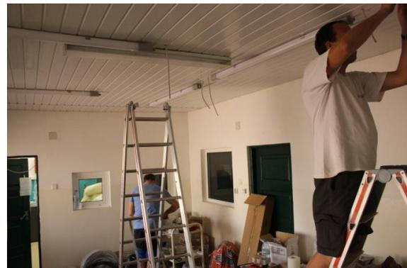
Die vorhandene Installation ließen wir unberührt und installierten parallel dazu komplett neu. Das ist wichtig, da wir dann ein autarkes Netz inkl. Solarstrom und eigenen Generator nutzen können. Wir haben nach Fertigstellung ca. 8KWp Solarenergie und 21KW Generatorleistung zur Verfügung. Die
