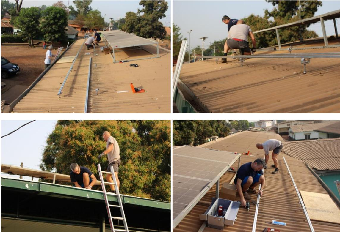
Gegen Mittag war das Gestell bereits montiert. Trotz 40-45°C Lufttemperatur und gefühlten 60°C auf dem Blechdach, entschieden wir uns, auch noch die Module zu verlegen und die Dacharbeiten an dem Tag abzuschließen.
