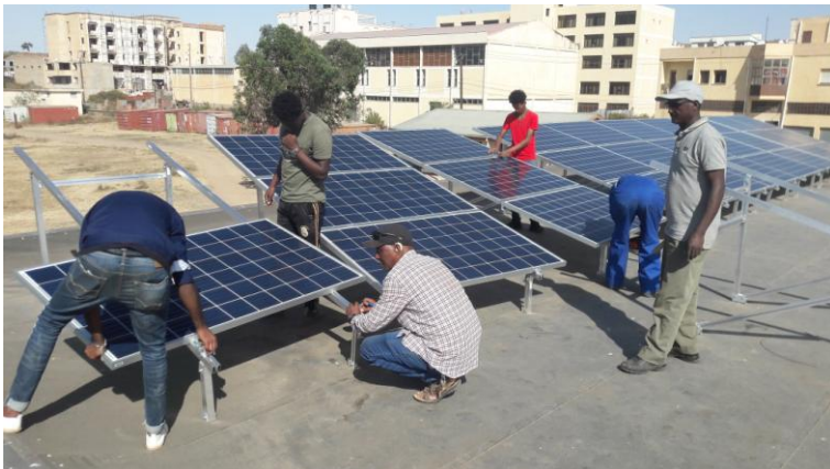
Aufbau der Solarpanels auf dem Dach der Brandverletztenstation
